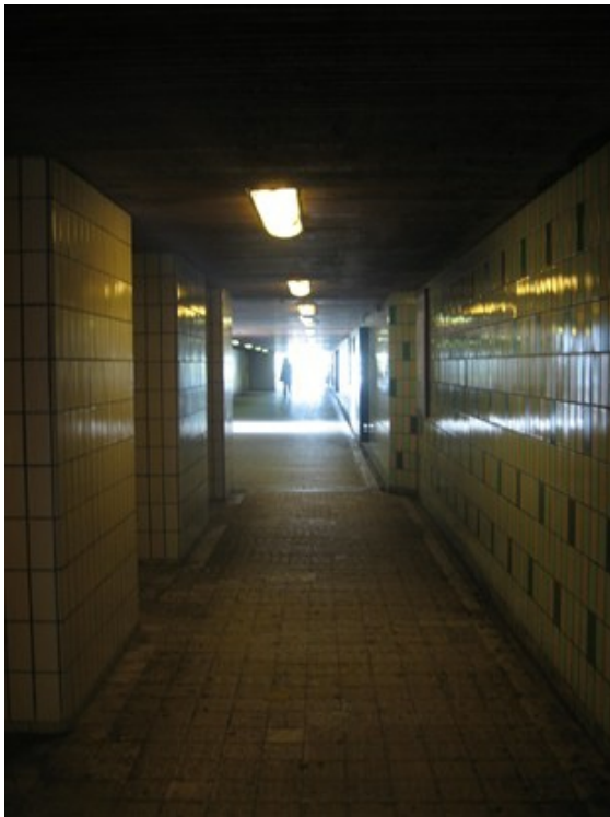
Blænding i tunnel. Foto: Silla Herbst.
