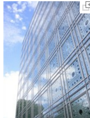
Indvendig afskærmning opbygget af et stort antal blænder tegnet af Jean Nouvel til Institut du Monde Arabe, Paris. Foto: Astrid Espenhain.
