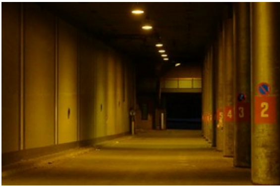
Belysning med højtryksnatriumlamper. Foto: Silla Herbst.
