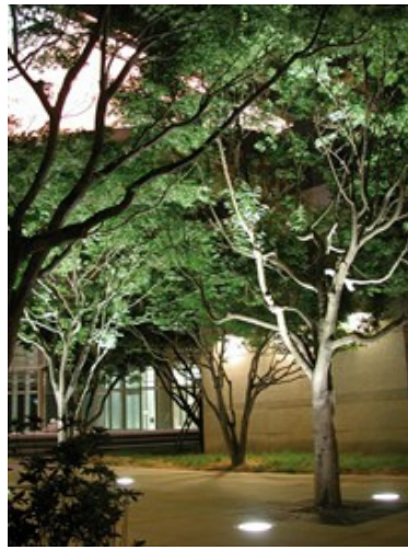
Eksempler på anvendelse af nedgravningsarmaturer. Fotos: Thorn (tv) og Simes/Fagerhult (th).
