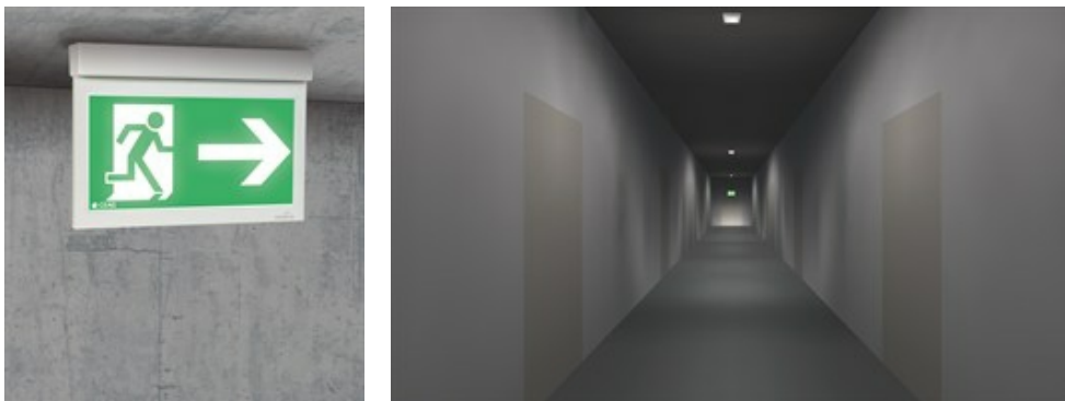
Flugtvejsarmatur (tv) og simulering af gang belyst af nødbelysning (th9). Fotos: Safeexit.
