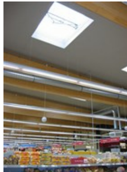
Ovenlyset i et supermarkedet i Berlin reducerer el-forbruget til elektrisk belysning. Foto: Werner Osterhaus.
