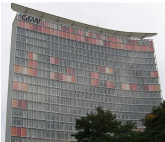
Farvede afskærmninger på vestvendt facade, GSW bygning i Berlin. Foto: Werner Osterhaus.
