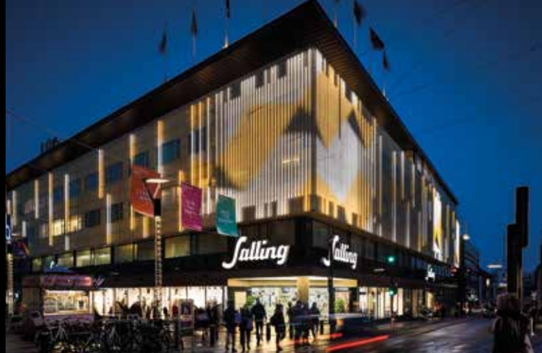
Mediefacaderne er opbygget af lineære LED-armaturer. Foto: Martin Professional.
