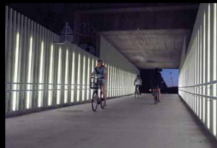
Nordhavns Station – sydlig passage. © Foto: Lighting, Sweco DK.
